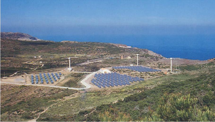
**Fig. 63 - Impianto misto da 1,56 MW fotovoltaico-eolico di Carloforte (Sardegna). Si nota il campo fotovoltaico da 600 kW<sub>p</sub>, suddiviso in tre sezioni e i tre aerogeneratori Medit WEST Aeritalia da 320 kW ciascuno (fotoriproduzione dal depliant Ansaldo distribuito all'inaugurazione)**
