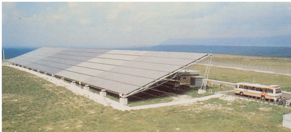
**Fig. 32 – Prima sezione dell’impianto Delphos da 300 kW<sub>p</sub> a Monte Aquilone (FG)** (dal depliant: “I laboratori fotovoltaici dell’ENEA”, Ed. ENEA, Dir. Centrale Relazioni, Roma, Luglio 1987)
