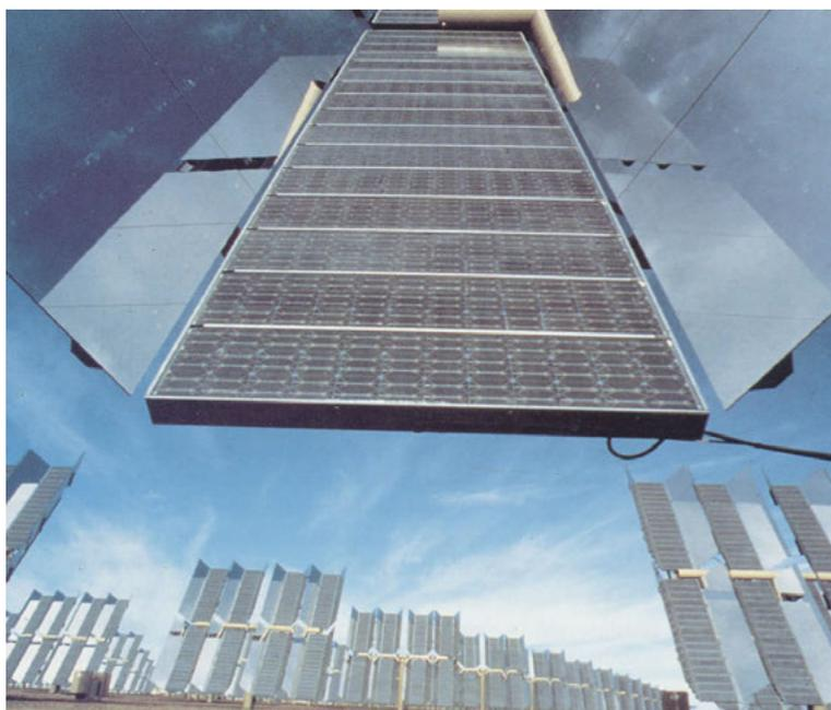
**Fig. 6 – Impianto di Carrizo Plain. Si notino le piastre riflettenti montate ai lati dei pannelli**
