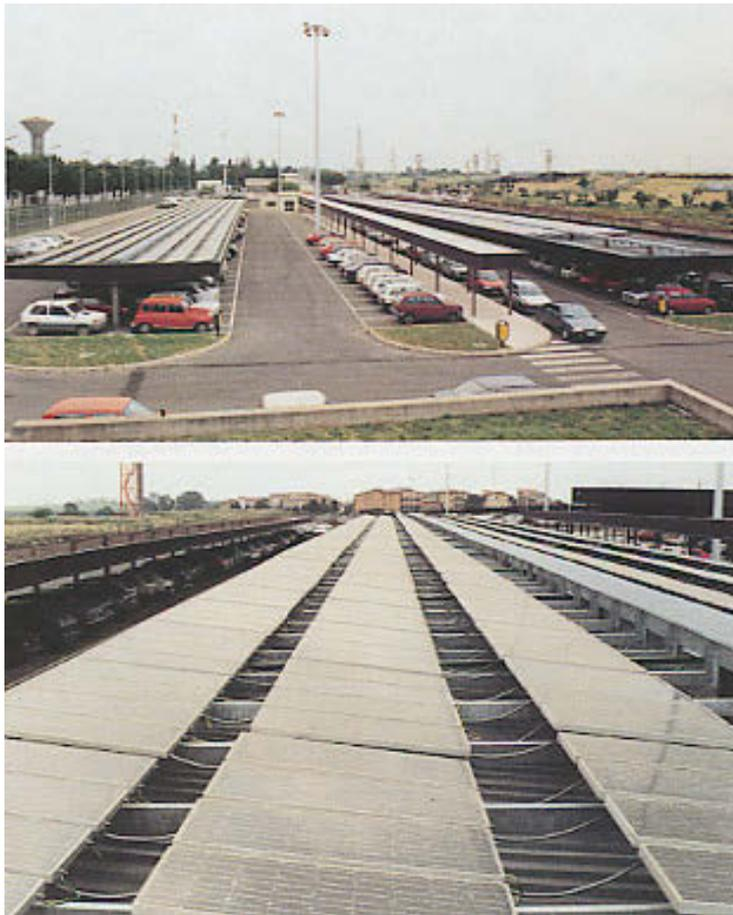
**Fig. 43 – Impianto PLUG da 100 kW<sub>p</sub>, collocato sopra le pensiline del parcheggio presso il Centro ENEA della Casaccia**
