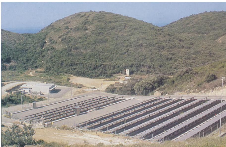
**Fig. 31 – Veduta d'insieme della centrale fotovoltaica dell'Isola del Giglio. Si noti a sinistra del campo fotovoltaico il magazzino frigorifero e al centro sotto la collina l'edificio di copertura del pozzo (foto da archivio dell'autore, 1984)**
