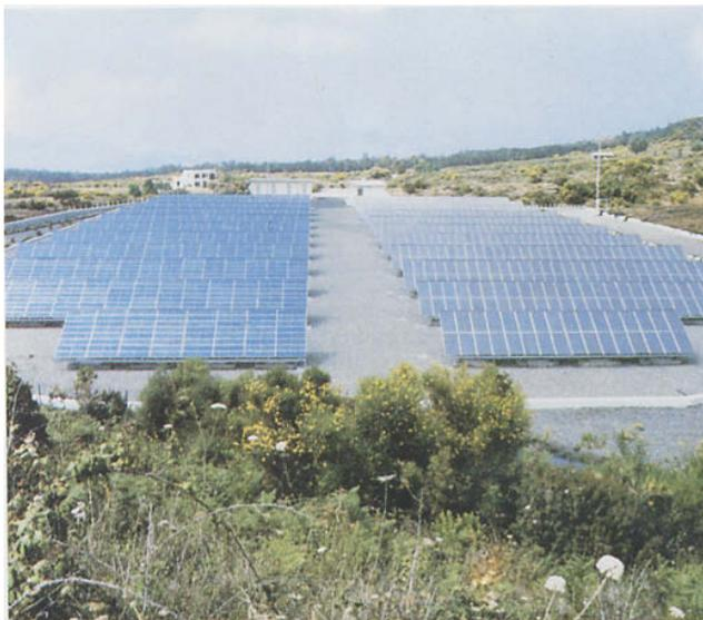
**Fig. 65 – Impianto da 80 kW<sub>p</sub> dell'Isola di Vulcano. Si notano i due semicampi realizzati rispettivamente dall'Ansaldo e dalla Pragma (foto tratta dal rapporto ENEL RICERCA – Fonti Rinnovabili e Risparmio Energetico, Impianto Fotovoltaico di Vulcano: Primi Risultati di Esercizio e Nuovo Inverter, Direzione Studi e Ricerche 1986)**
