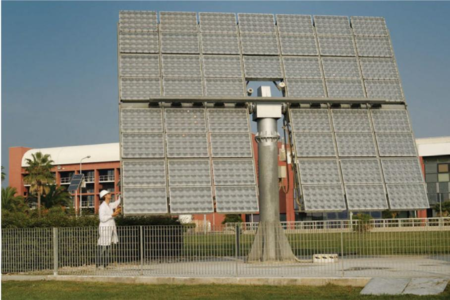
**Fig. 56 – Impianto modulare fotovoltaico da 5 kW<sub>p</sub> a concentrazione “Phocus” in prova a Portici nel 2007 (fotografia messa a disposizione dall’archivio ENEA)**
