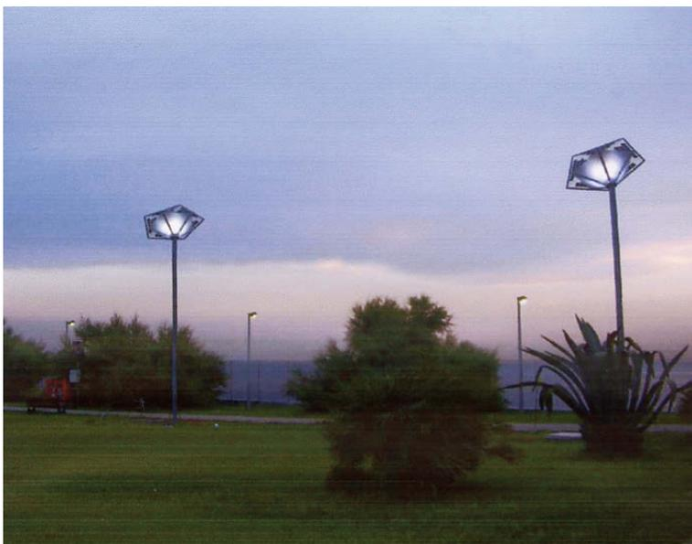
**Fig. 61 – Lampioni fotovoltaici *Stapelia* in funzione al Centro di Portici**
