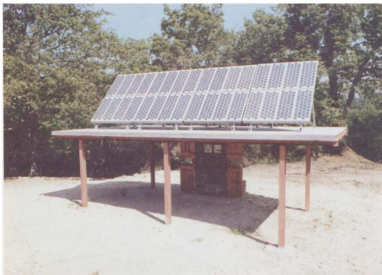
**Fig. 35 – Pannello fotovoltaico dell'impianto di Castel Porziano. Si può vedere l'alloggiamento degli apparecchi elettronici di controllo della potenza e degli accumulatori collocato al riparo sotto la tettoia che sostiene i moduli fotovoltaici**
