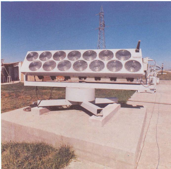
**Fig. 23 – Impianto fotovoltaico da 100 W<sub>p</sub> a concentrazione ottica 50x con lenti di Fresnel delle Officine Galileo e celle Ansaldo AC50 in funzione nel 1981 presso la Stazione Sperimentale Fotovoltaica del CSN-Casaccia (Coiante, 1984)**
