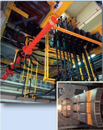
Figura 49 – Impianto di riscaldamento ausiliario a radiofrequenza LHRF installato su FTU: le guide d'onda (foto grande) e l'antenna attraverso la quale le onde vengono lanciate nel plasma (foto piccola).
