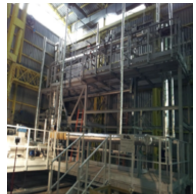
Impianto HELENA: sezione di prova FIVFPS in alto e, in basso, circuito primario
