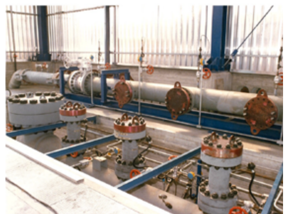
Flange da 10" e 24" per l'installazione delle valvole da provare
