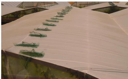
**Ventilazione naturale mediante aperture sul colmo della serra**
