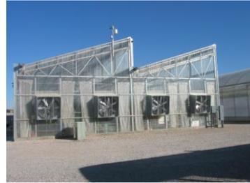
**Sistema fan-pad in serra con tipologia a struttura asimmetrica**
