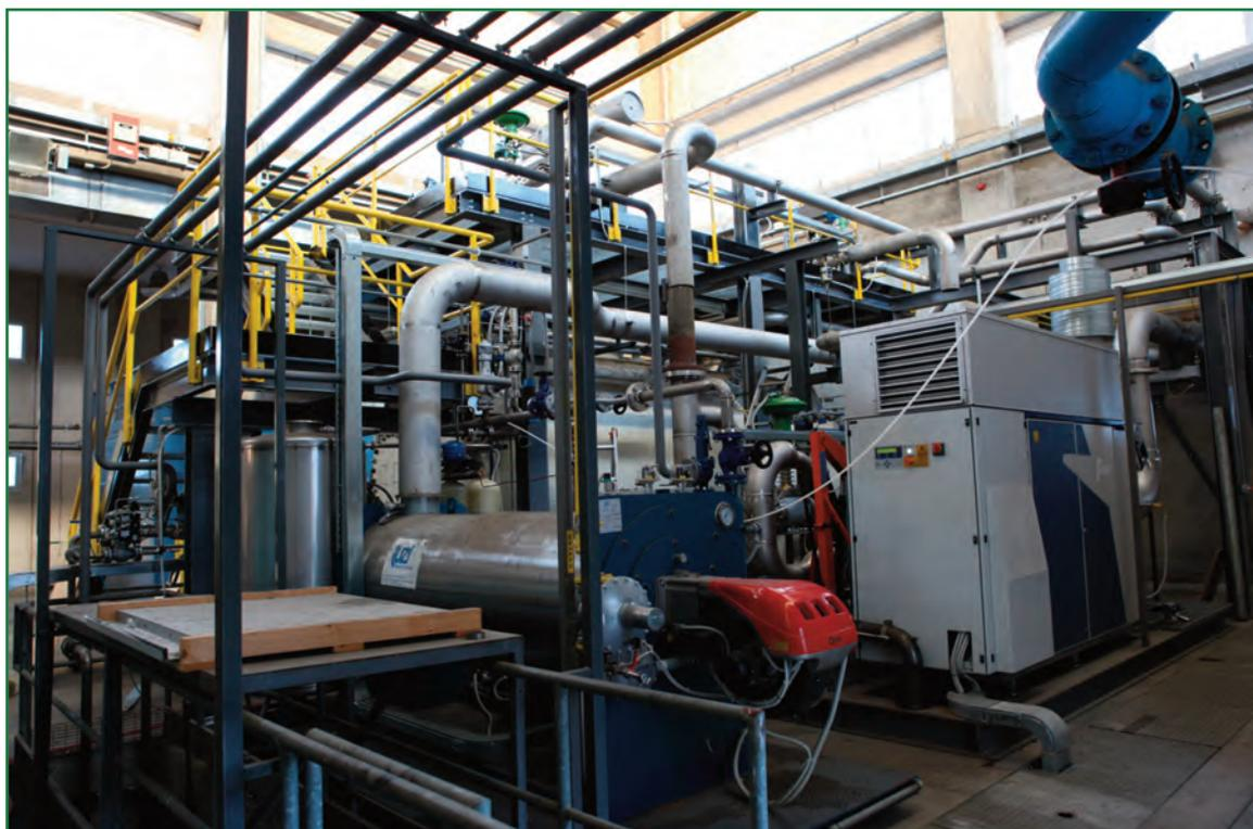
A sinistra, in primo piano, il generatore di vapore da 700 kWt. A destra la  $\mu\text{TG}$  Turbec T100 da 100 kWt
