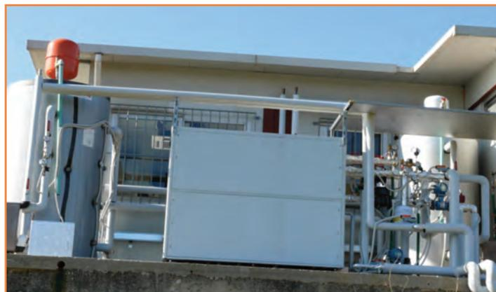
Impianto AI.CO.WA.: pompa di calore a R744 (CO<sub>2</sub>)
