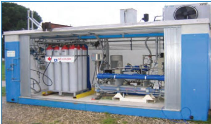
Minirete per il rifornimento di idrogeno, metano e miscele ad alta pressione
