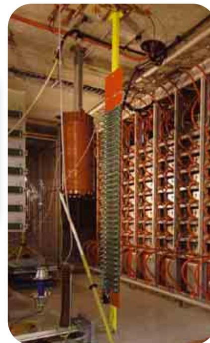
Alimentatore elettrico ad alta tensione per l'impianto di prova europeo del sistema di riscaldamento ECRH di ITER - *High voltage power supply for the European test facility of the ECRH heating system for ITER (OCEM)*
