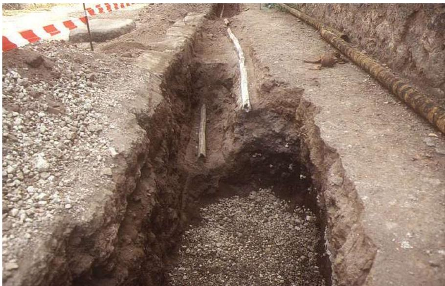
**Fig. 3 - Fistulae in fase di smontaggio lungo Via di Nola**
