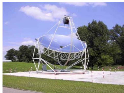
Fig. 10 - Sistema a disco parabolico Eurodish (CESI)
