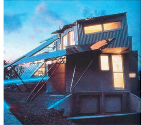
Il secondo caso (*figura A.14*) mostra invece un'applicazione retrofit in facciata, nella quale il componente fotovoltaico non è propriamente impiegato come componente edile, ma semplicemente sovrapposto alla struttura della facciata; si tratta, più che altro, di un ingegnoso sistema di montaggio che consente di ottenere il posizionamento ottimale dei moduli ed un effetto decorativo del prospetto.
