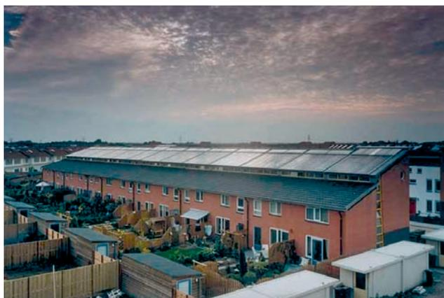
Nella fase istruttoria del progetto era stato stabilito un limite massimo di riduzione del rendimento del sistema, dovuto ad effetti di ombreggiamento o di orientamento non ottimale, pari al 5%, inoltre l'inclinazione della copertura di ognuno degli edifici doveva essere compresa tra 20° e 50°.
