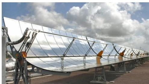
*Modulo di Concentratore Solare Parabolico*
