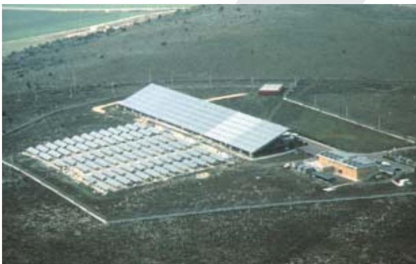
Veduta aerea dell'impianto fotovoltaico Delphos in cui sono visibili la prima sezione "a vela" (a destra) e la seconda sezione (a sinistra)
