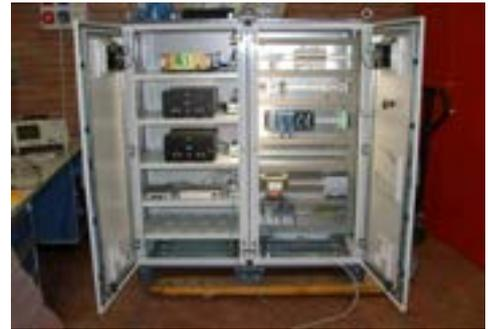
Figura 25. Armadio DAQ per i sensori di cavitazione e per il resistivity meter
