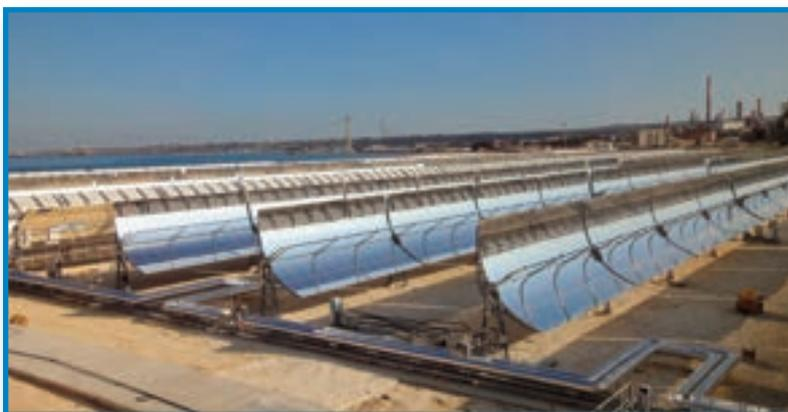
Questo calore può essere integrato con altra fonte esterna di energia (ad es. gas o biomassa) per la produzione di energia elettrica o per essere utilizzato a più alta temperatura in processi industriali. La tecnologia disponibile consente anche l'accumulo del calore per un successivo utilizzo.
