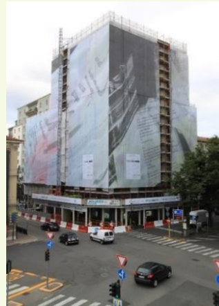
La fase di cantiere
