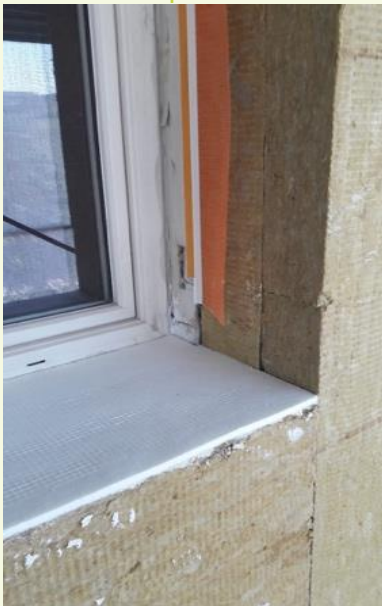
Isolamento della spalletta e del davanzale
