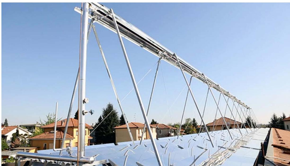
Figura 24 - Impianto CSP-F per solar cooling a Gorla Maggiore
