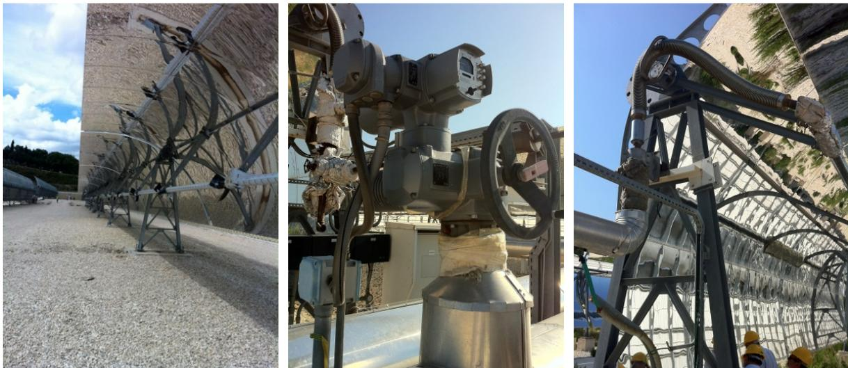
*Figura 74 - CSP SAREA: collettore lineare, valvole per sali fusi e tubazioni flessibili presso l'impianto ASE*
