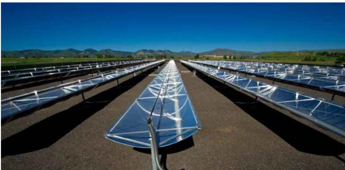
*Figura 18 - Collettori solari parabolici per calore di processo PT-1 – Abengoa di Minera El Tesoro*
