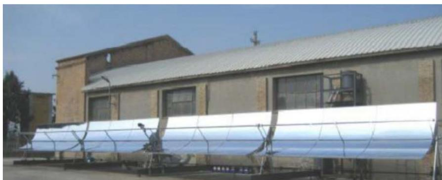
*Figura 22 - Collettori per l'impianto pilota di solar cooling di Soltigua*
