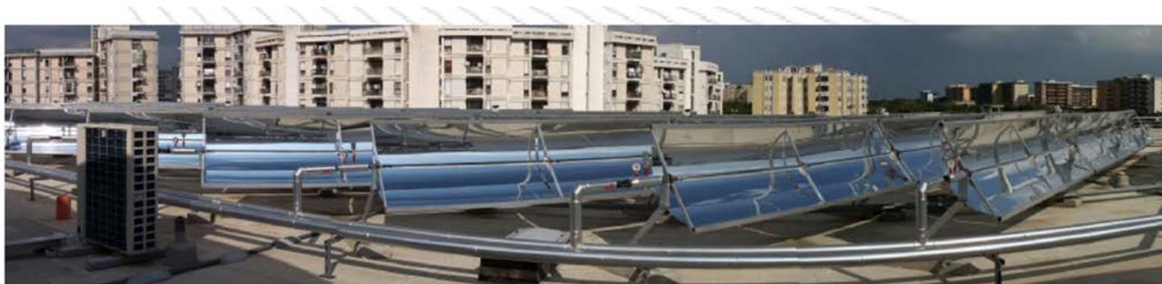
Figura 23 - Collettori Solar System Wing EVO di Trivelli Energia
