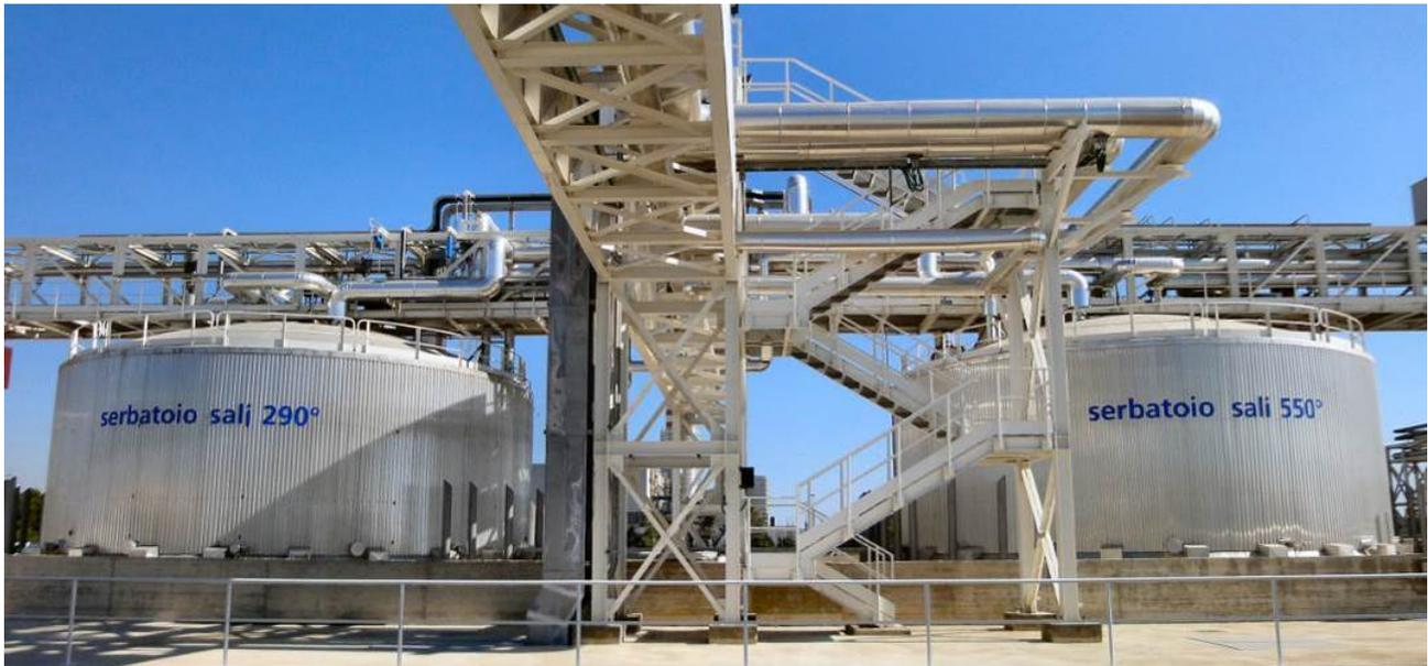
*Figura 36 - Sistema di accumulo termico (serbatoio freddo e caldo) dell'impianto Archimede*
