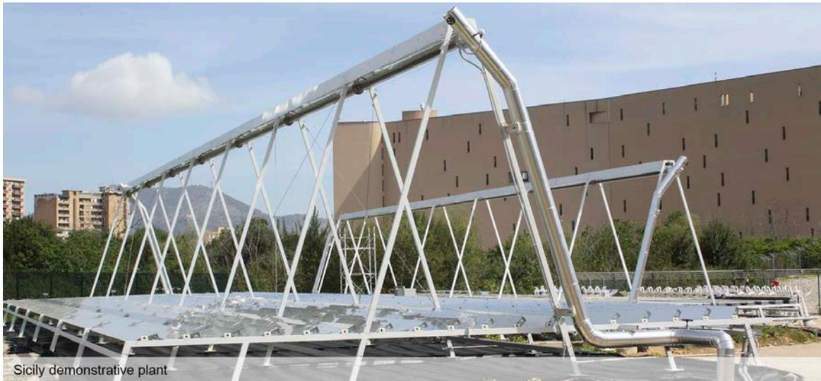
*Figura 31 - Vista dell'impianto solare STS-Med Università di Palermo*
