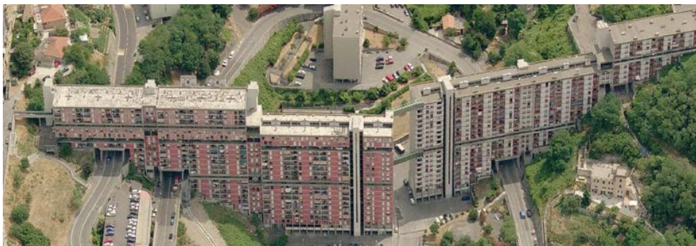
Figura 1. Le Dighe di Begato
